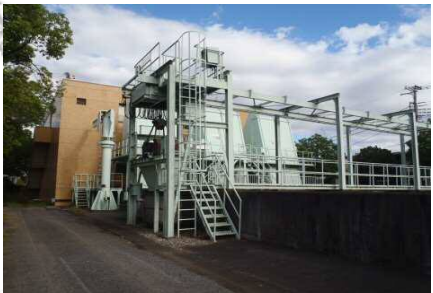
御料堀ポンプ場
